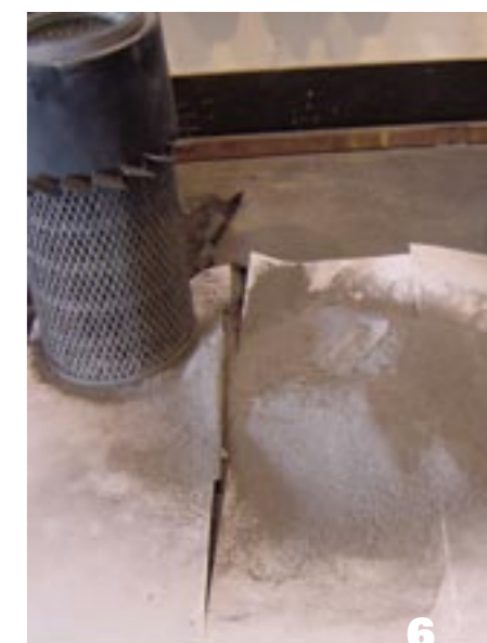
5. Dans une fonderie d'aluminium à Dubaï des filtres à air ont été montés sur les contrepoids des appareils afin d'accroître la durée de vie du moteur et d'éviter les problèmes d'entretien que pose ce type d'usage. 6. La poudre d'alumine, fine et légère, cause des difficultés en particulier au niveau des filtres.
